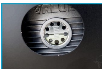
KONTROLA POZIOMU OLEJU W KOMPRESORZE
